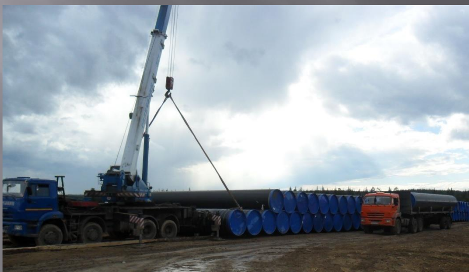
Укладка ТБД в штабель, БВХ «Солянка»
